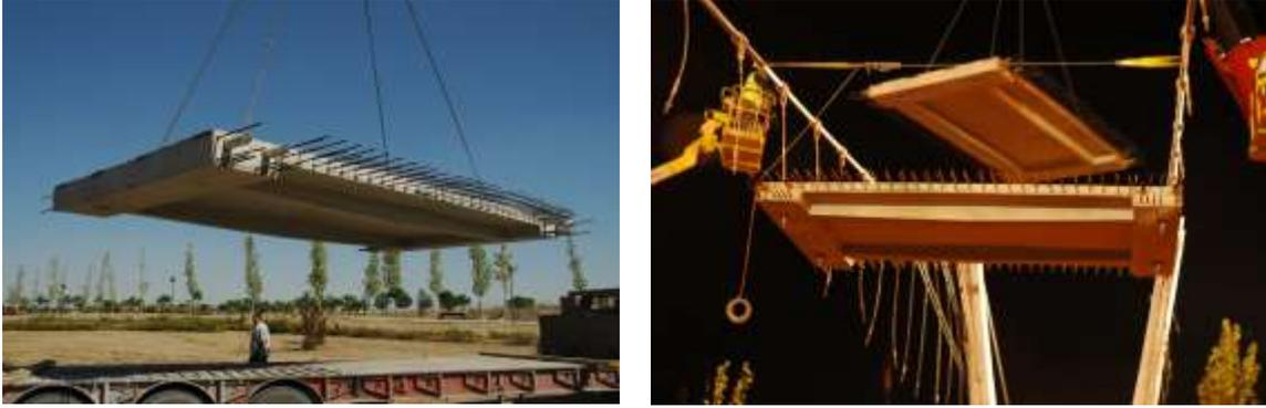
Fig. 8 Dovelas prefabricadas del tablero
