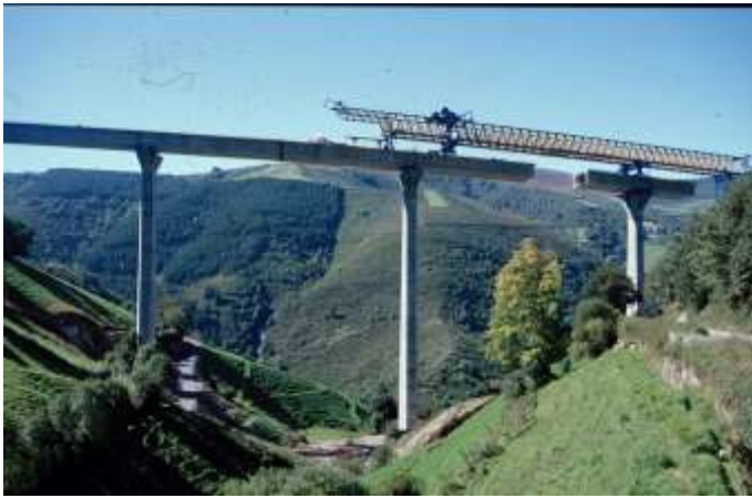
Ferreiras viaduct. Piedrafita. Lugo. Spain (1999)
