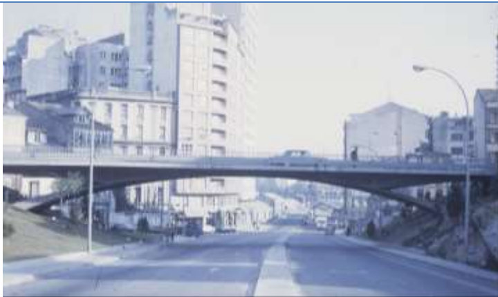
Juan Flórez overpass. La Coruña. Spain (1973)
