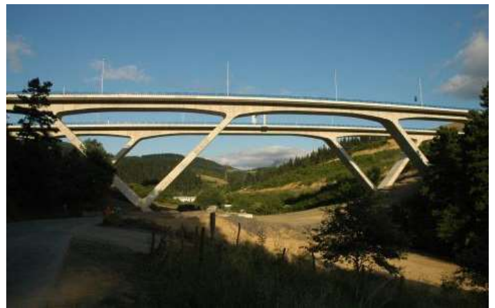
Basagoiti viaduct. Guipúzcoa. Spain (2009)
