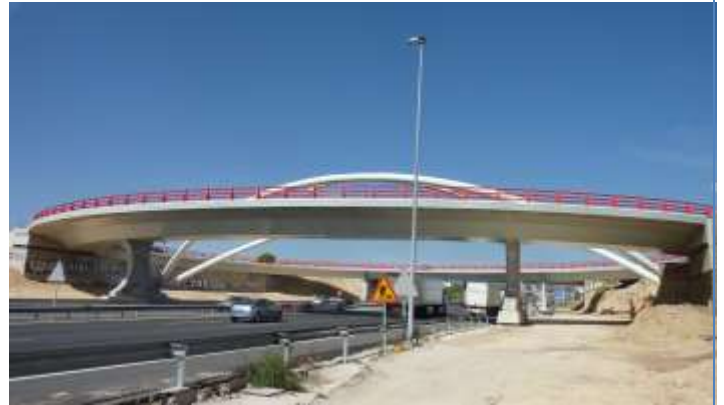
Viaduct over the A-6 highway. Las Rozas. Madrid. Spain (2011)
