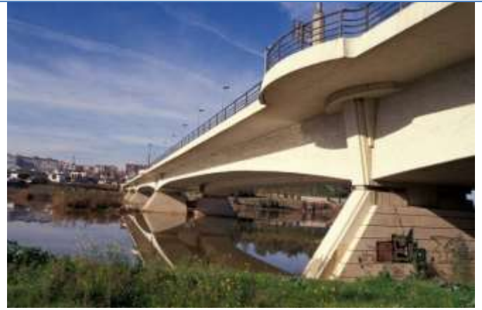
Autonomía Bridge over the Guadiana River. Badajoz. Spain (1988)
