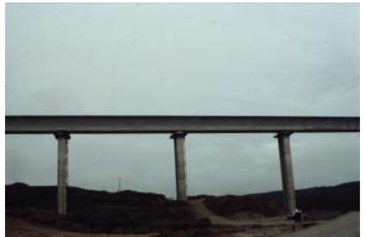
Los Monegros aqueduct. Huesca. Spain (2003)
