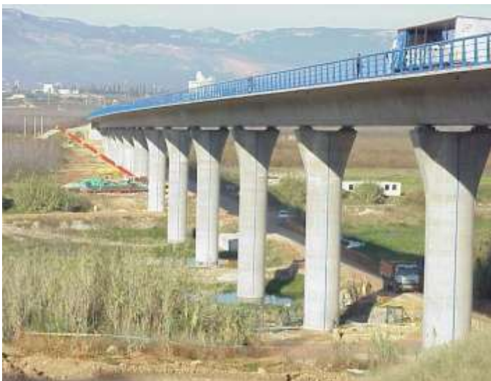
Viaduct over the Francolí River. Tarragona. High speed line Lleida-Barcelona. Spain (2002)
