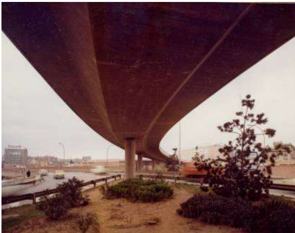
Ildefonso Cerdá viaduct. Barcelona. Spain (1971)
