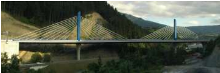
Arbizelai viaduct. Guipúzcoa. Spain (2009)
