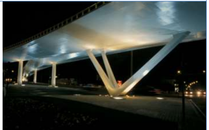
Puente de los Franceses viaduct. Madrid. Spain (1998)
