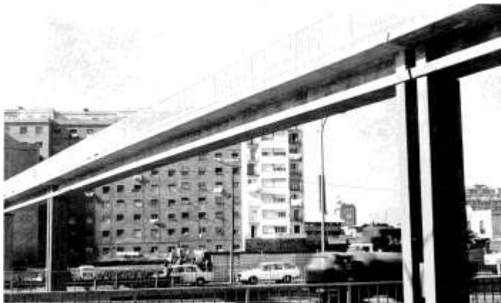
Precast footbridge – Tipo. Barcelona. Spain (1973)
