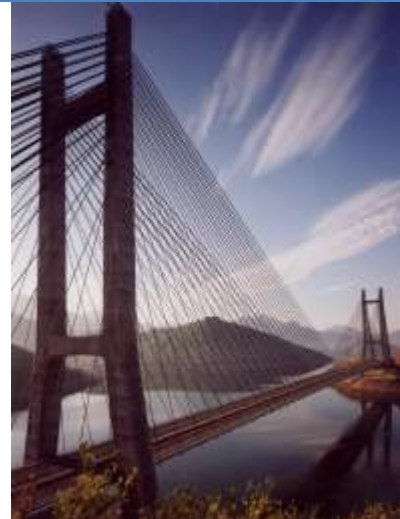
Carlos Fernández Casado Bridge over the Barrios de Luna reservoir. León. Spain (1983)
