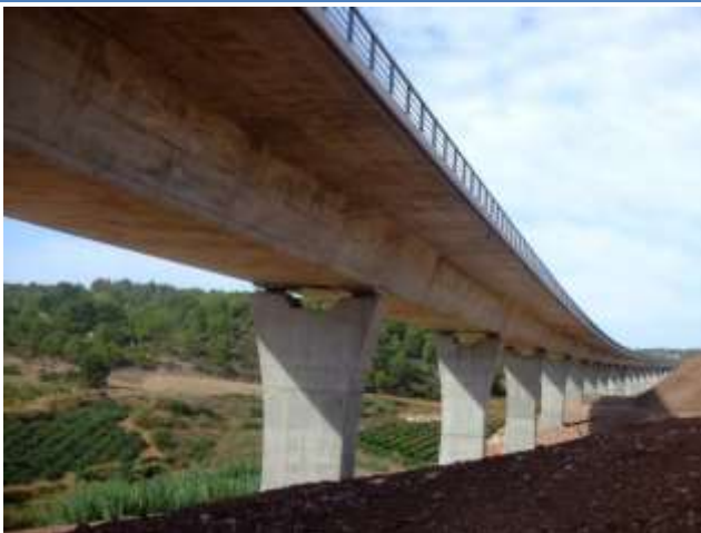
Huertas de Mateo viaduct. Cuenca. Spain (2008)
