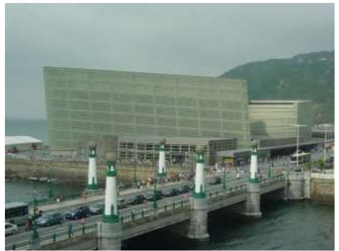
Kursaal auditorium. San Sebastián. Guipúzcoa. Spain (1995) Arq. R. Moneo
