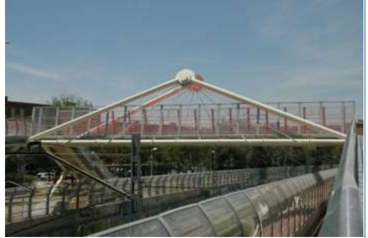
Entrevías Footbridge. Madrid. Spain (2007)
