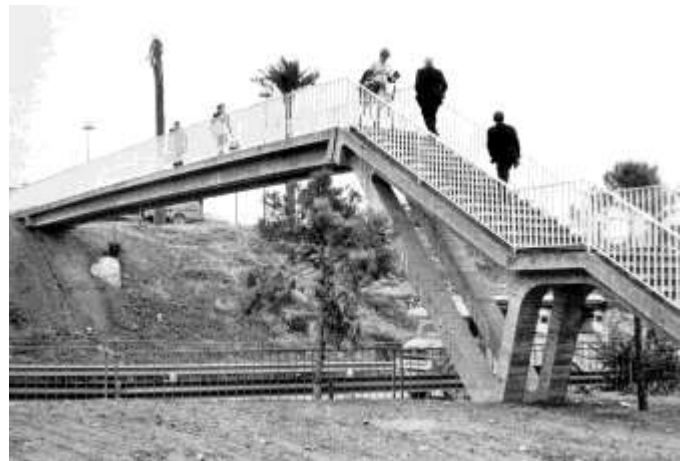
Footbridge in Plaza de las Glorias . Barcelona. Spain (1973)
