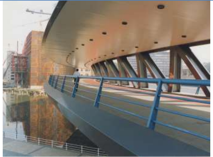
Euskalduna Bridge over the Nervión River. Bilbao. Spain (1999)
