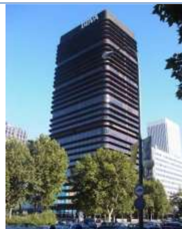
Banco de Bilbao tower. Madrid. Spain (1975-76) Arq: F.J. Saenz de Oiza
