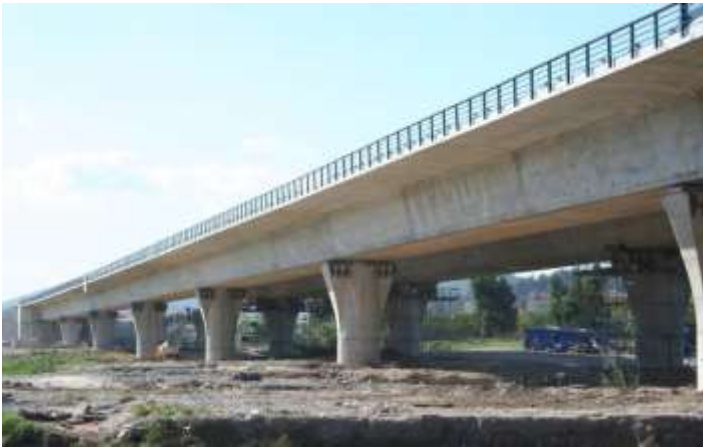
El Papiol viaduct. High speed line Lleida-Barcelona. Spain (2006)
