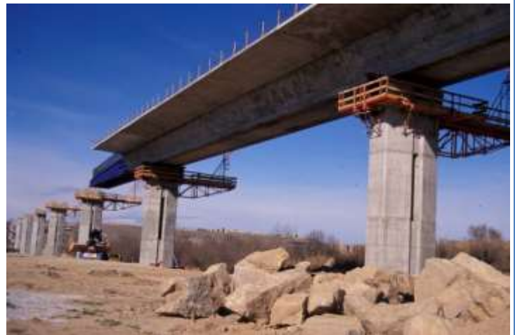
Viaduct over the Segre River. Lleida. High speed line Lleida-Barcelona. Spain (2002)
