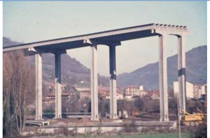
Campomanes Bridge. León. Spain (1981)
