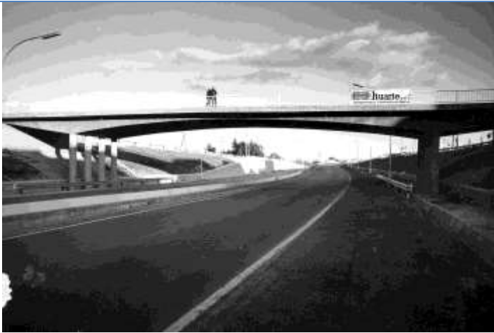
Overpass in Las Rozas . Madrid. Spain (1969)
