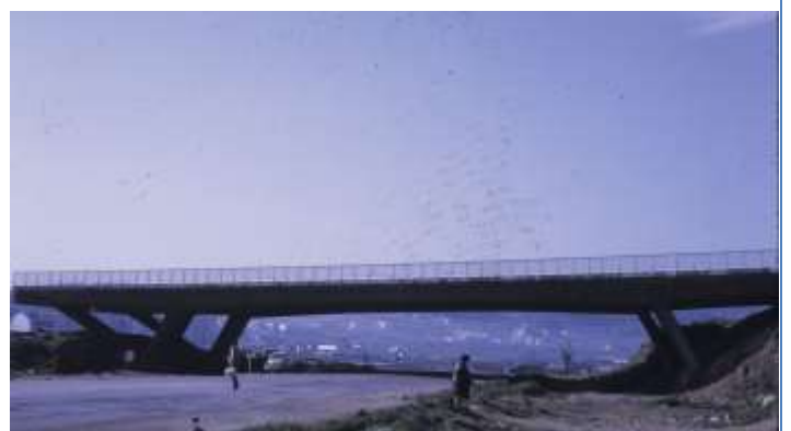
El Alcalde overpass. La Coruña. Spain (1973)
