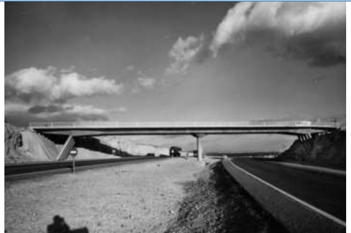
Overpass over the A-6. Hoyo de Manzanares. Madrid. Spain (1969)
