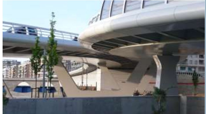
Vial de Borde viaduct. San Sebastián. Spain (2009)
