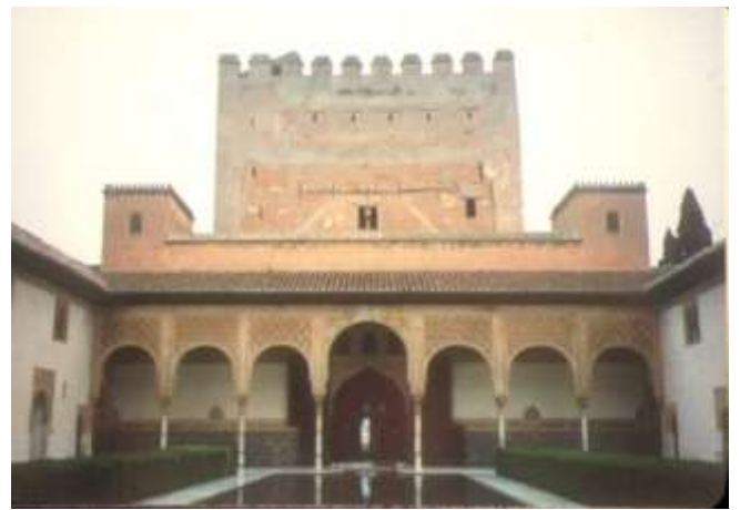
Estructural evaluation of the Torre de Comares . (S XIV). La Alhambra. Granada. Spain (1995)
