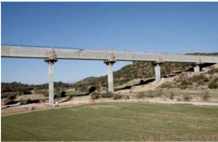
Segarra-Garrigues aqueduct. Lleida. Spain (2006)
