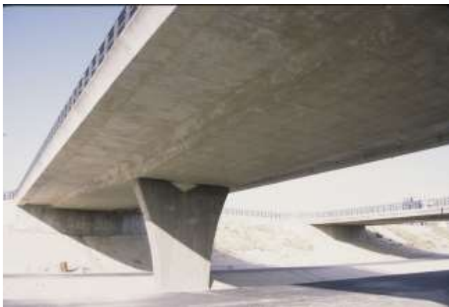
Business park Pinar de las Rozas Bridge. Madrid. Spain (1992)
