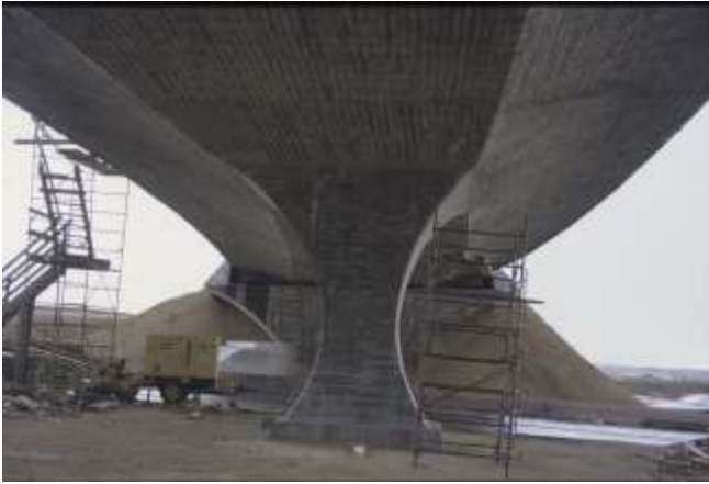
Urbanización Nuevo Versalles overpass. Madrid. Spain (1993)
