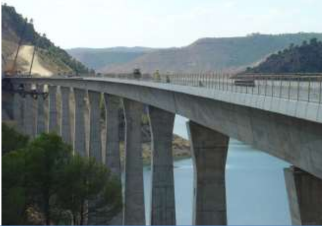
Istmo viaduct. Cuenca. Spain (2009)
