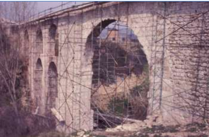
Rehabilitation of San Pere de Ruidevitlles aqueduct (S XIII)
