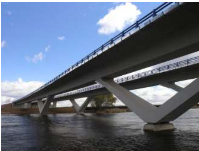
Viaduct over the Duero River in la Autovía de la Plata. Zamora. Spain (2008)
