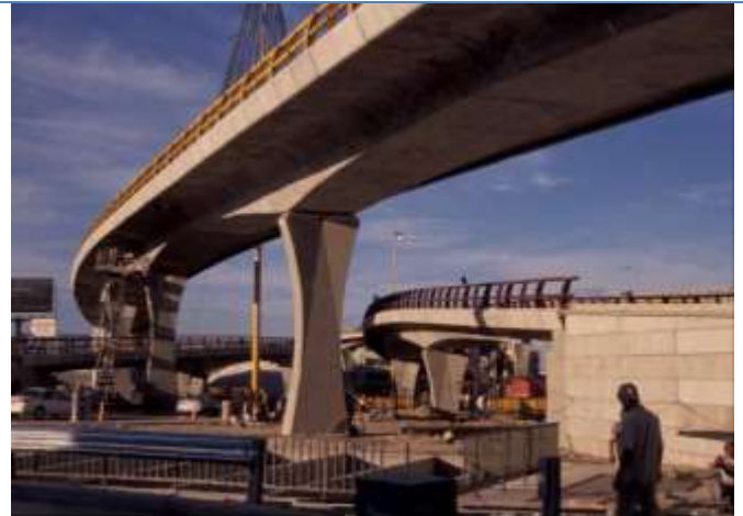
Venustiano Carranza viaduct. Saltillo. Mexico (2002)
