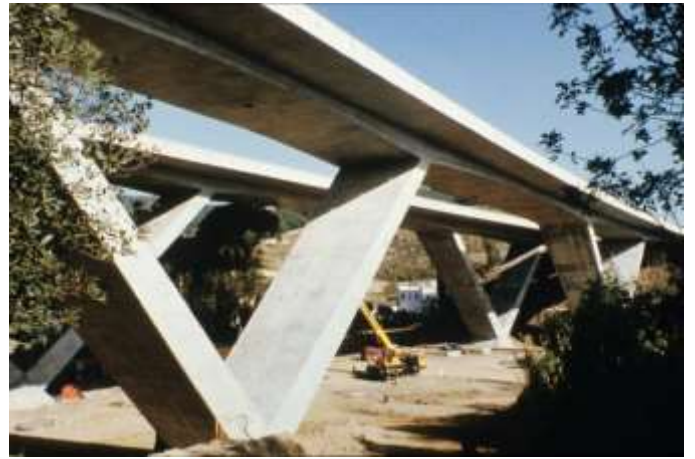
Riera de L'Ubo viaduct. Barcelona. Spain (1993)
