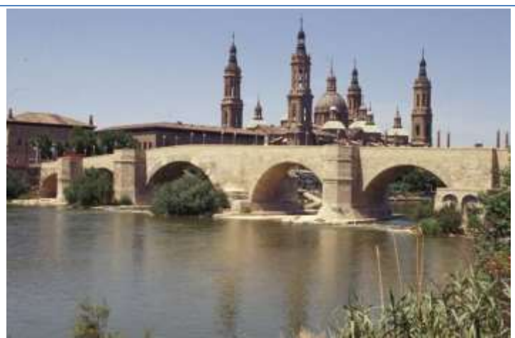
Rehabilitation of Puente de Piedra (S XIII) Zaragoza. Spain (1988)
