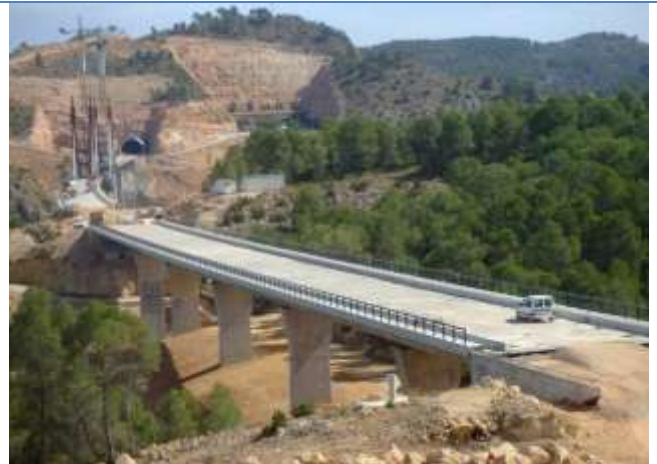
Cuesta Negra viaduct. Cuenca. Spain (2008)
