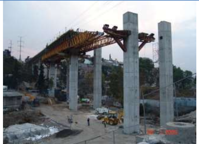
Eje 5 Poniente viaduct. Mexico (2005)
