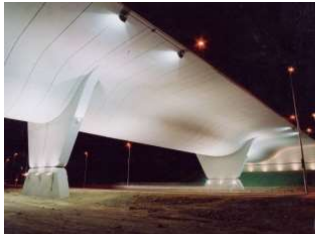
Ronda de la Hispanidad viaduct. Zaragoza. Spain (2002)
