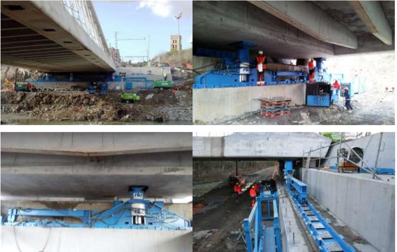
**Figura 10. Gateo y ripado del puente. Patines y carriles de deslizamiento**
