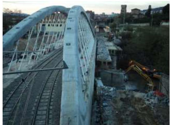
**Figura 8. Demolición de la estructura existente**
