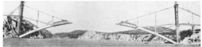
Fig. 16a. Construcción del puente de Sibenik
