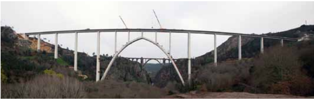
Fig. 1c. Puente sobre el río Ulla (L=179 m)
