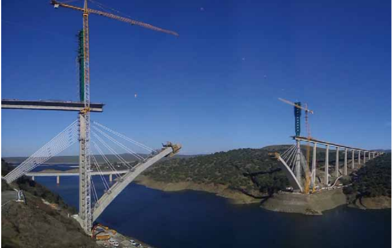
Fig. 8. Vista general del viaducto en construcción
