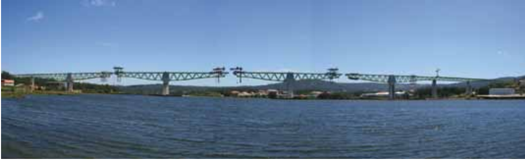
Fig. 1b. Puente sobre la ría del Ulla (L=240 m)
