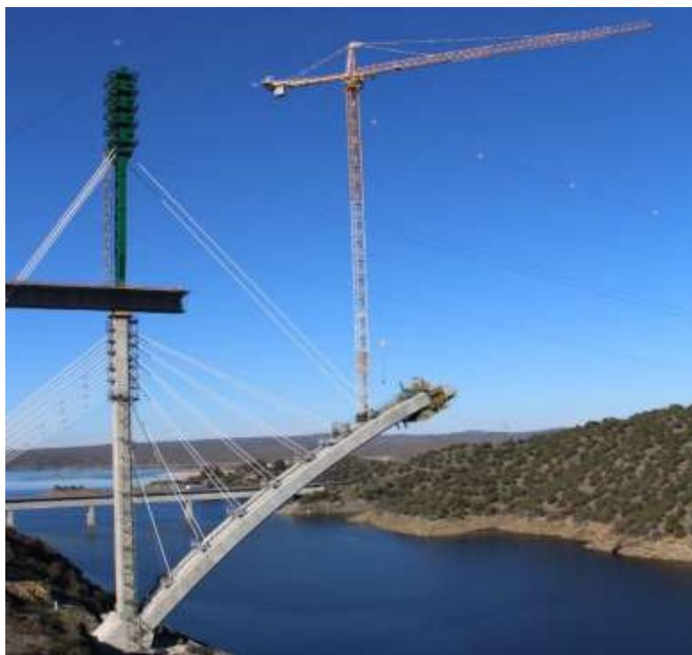
Fig. 4: Posición sobre arco de la grúa de 85 m de altura en dovela 20. Se observa la pareja 7 de tirantes delanteros cerca del arranque de la grúa, que van a conectarse con la torre de atirantamiento. Nótese las 6 familias de tirantes que van a la pila.
