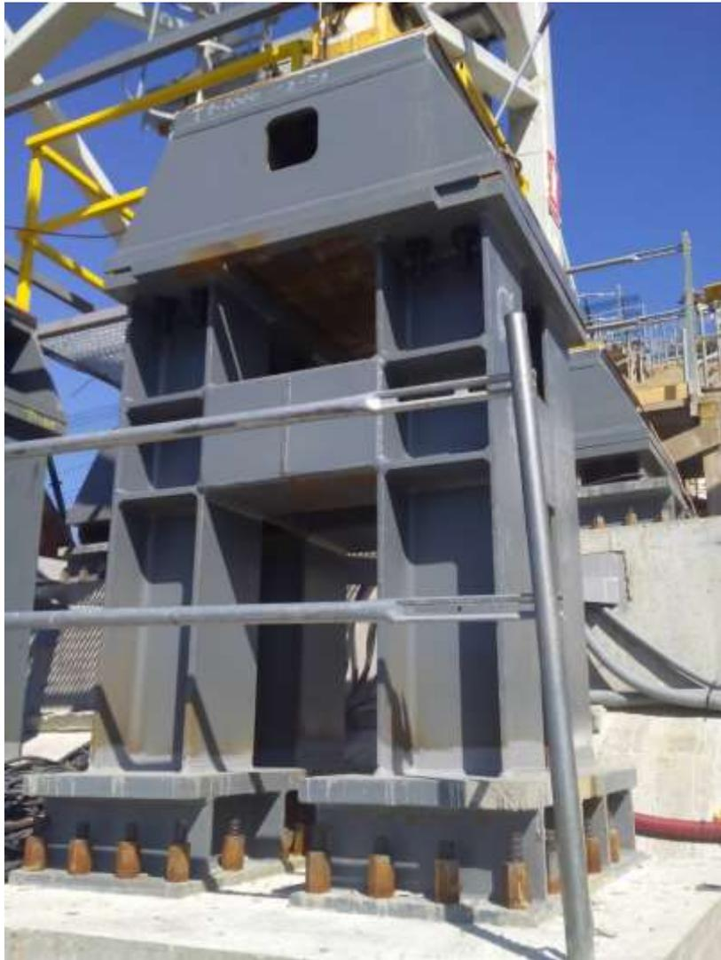
*Fig. 6: Estructura de anclaje de la grúa 1 sobre arco.*
