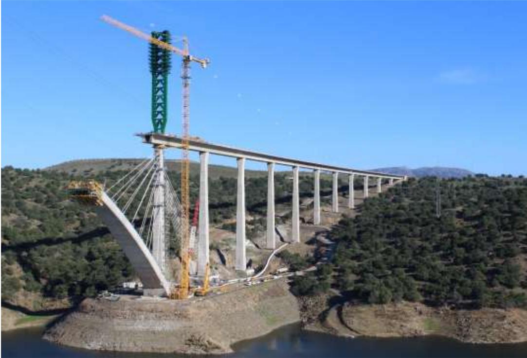
*Fig. 2: Momento en el que la grúa sobre zapata se destelescala para cambiar a la posición 2 sobre arco. Ya se aprecia más baja que la torre provisional de atirantamiento.*
