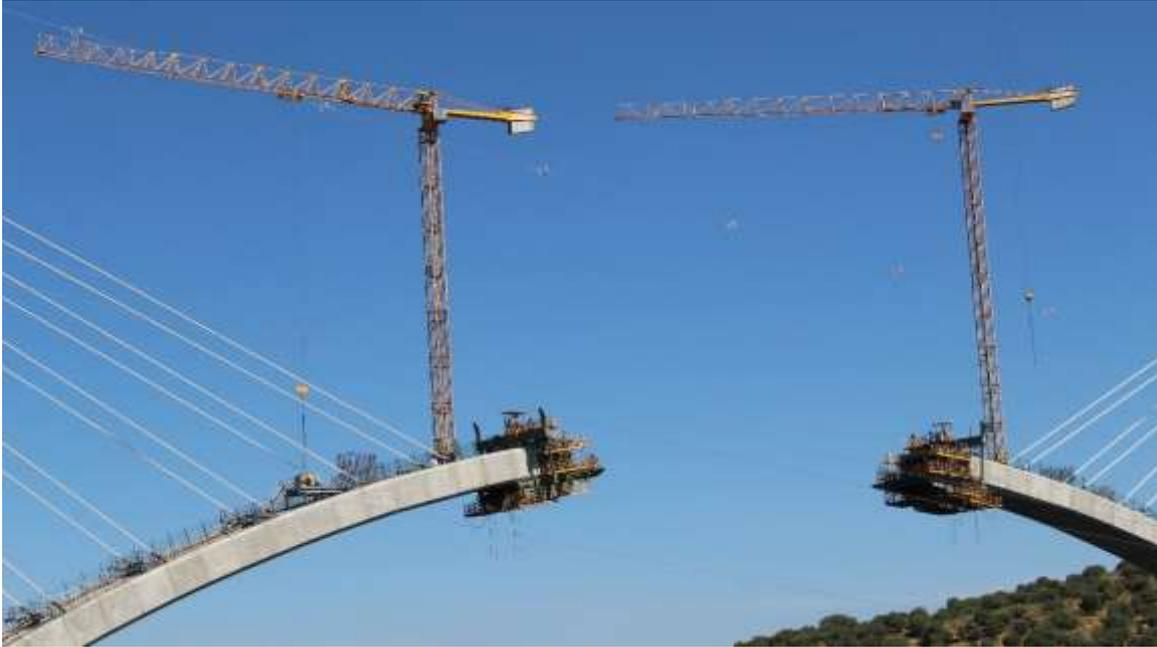
Fig. 5: Detalle de las grúas 3 y 4. La grúa de la izquierda se encuentra colocando cargas en la plataforma de intercambio. Se aprecia la escala gracias a los operarios en la plataforma.
